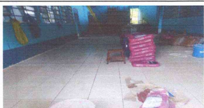
Foto 4: El salón para reuniones en su totalidad de colocación de piso.
