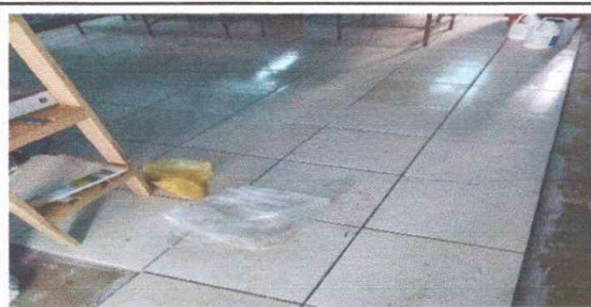
Foto 3: La dirección casi en su totalidad de colocación.
