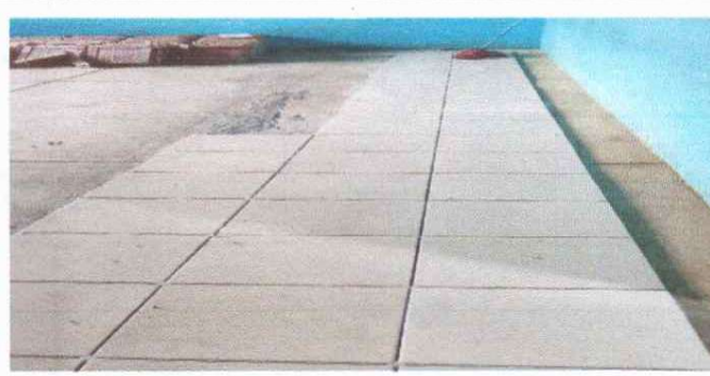
Foto2: Aula 1 avanzando en la colocación.
