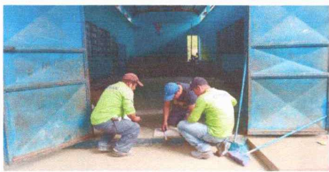
Foto1: Así dio a inicio en el salon para reuniones para que quedara nivelado el piso en todos los ambientes.
