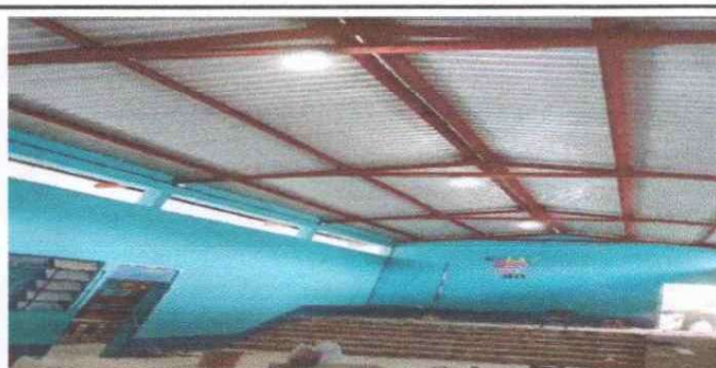
Foto 6: Prueba de la iluminación de cableado y focos en el salón
